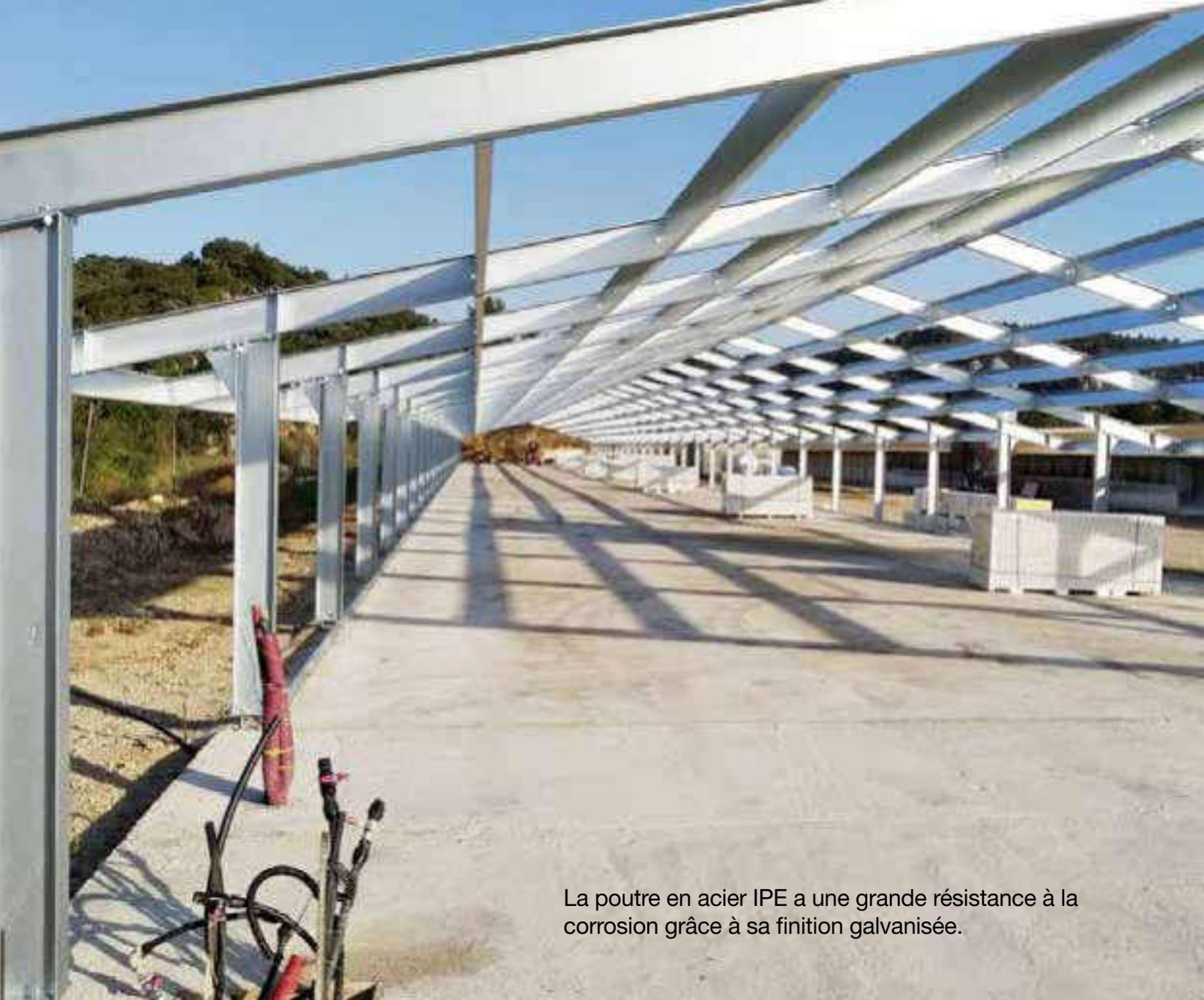
La poutre en acier IPE a une grande résistance à la corrosion grâce à sa finition galvanisée.
