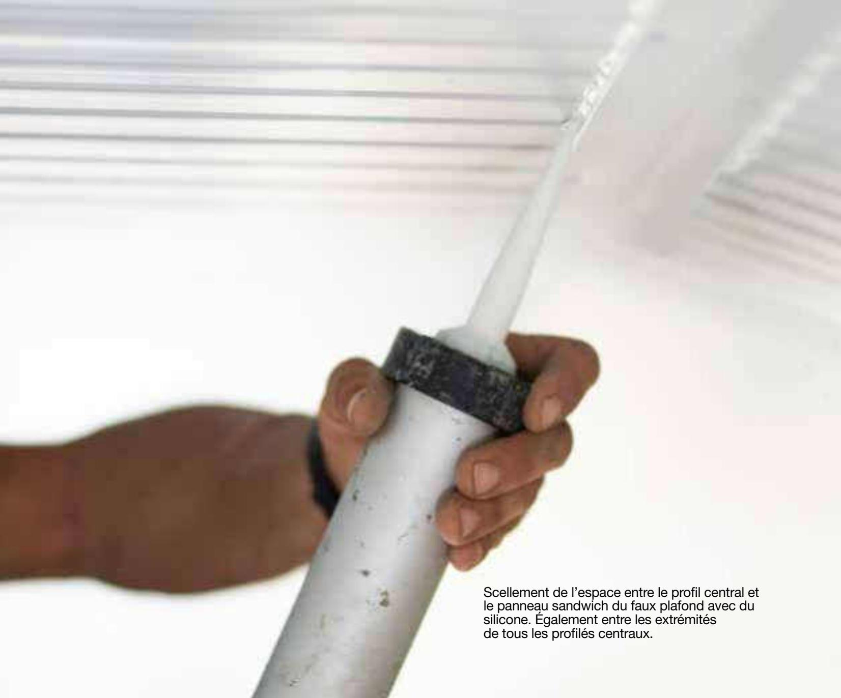
Scellement de l'espace entre le profil central et le panneau sandwich du faux plafond avec du silicone. Également entre les extrémités de tous les profilés centraux.
